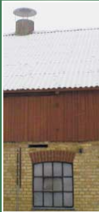
En självdragstrumma och tilluftshål direkt genom ytterväggen i varje box är en enkel typ av naturlig ventilation. FOTO: Michael Ventorp
